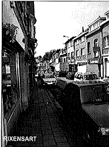
Des trottoirs trop étroits et souvent dégradés rue de Rosières, mais des contraintes spatiales importantes limitent les possibilités d'aménagement.
